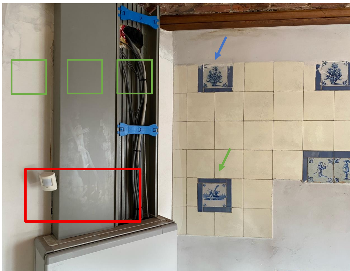
Afb. 9. Kabelgoot bovenaan de elektriciteitskast met zicht op de elektriciteitskabels en de achterliggende PVC-plaat. Het rode en de groene kaders geven de plaats aan waar respectievelijk het tegeltableau en de drie tegels met drietulpdecor zich bevinden/bevonden (foto: auteur)
